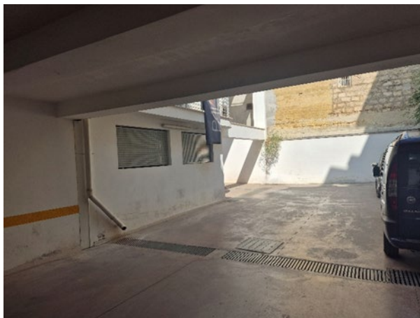
USCITA SU RAMPA
