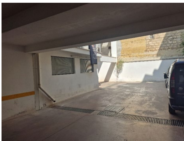
USCITA SU RAMPA
