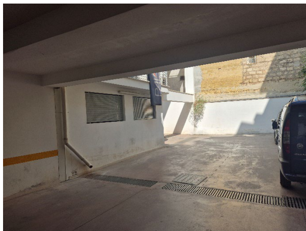
USCITA SU RAMPA
